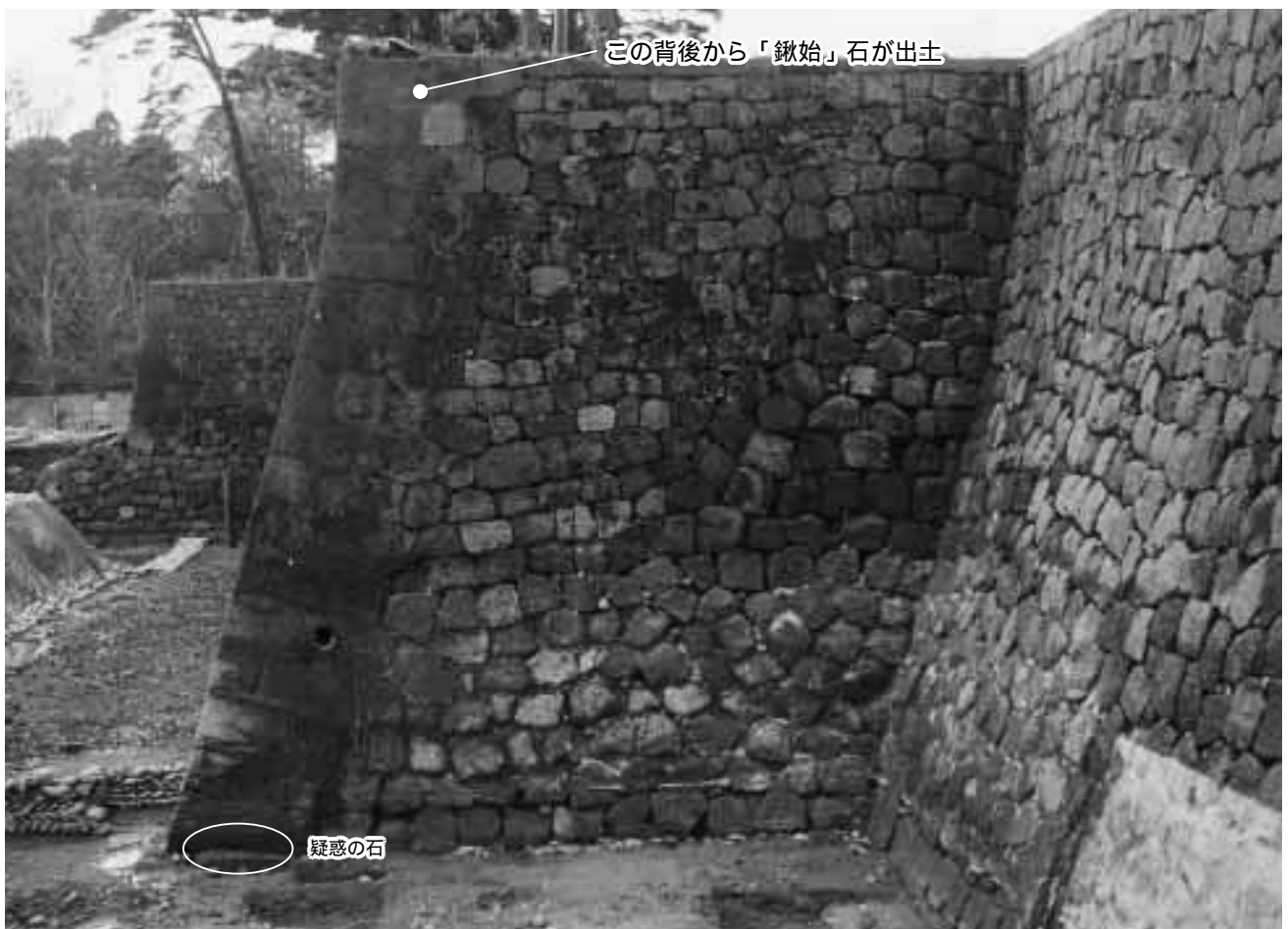
写真2 五十間長屋台北面石垣（宝暦13年の改修ラインが見える）
