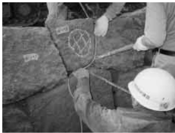
写真1 石垣の解体風景
