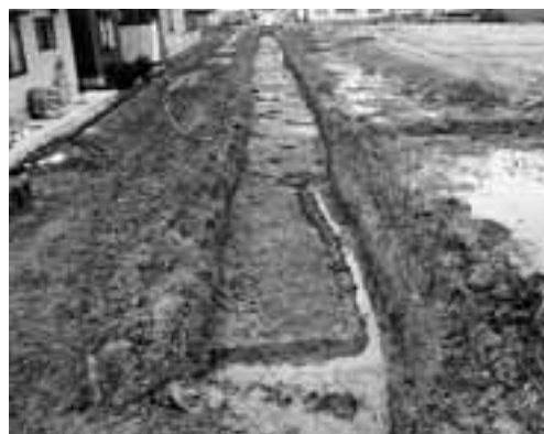
B区完掘状況 (南から)
