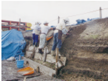
上から順に壁を削っていきます高いところは板を足場にして...
