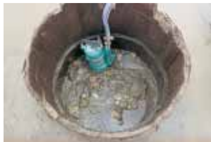
結桶内には「ろ過」の役割を担った礫が敷きつめられていました
