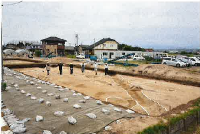
[3区] 古代の道路状遺構と道幅 (南西から)
