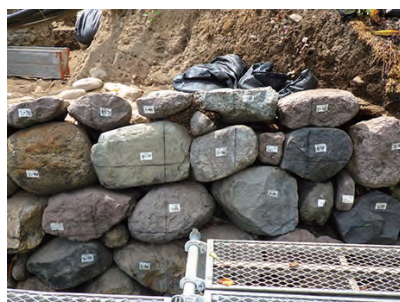
写真4 石垣へ墨打ち
