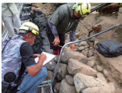
写真5 築石の寸法・重さの記録
