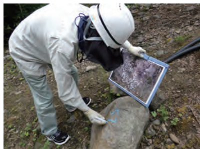
写真1 崩落石材の仮番付
